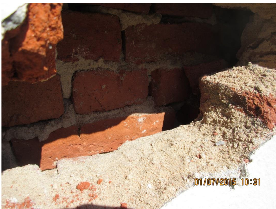
Foto 11: Fotoet viser 110 mm tegl i facaden opmuret i ren kalkmørtel, 50 mm hulmur og bagvedliggende massiv 240 mm mur.
