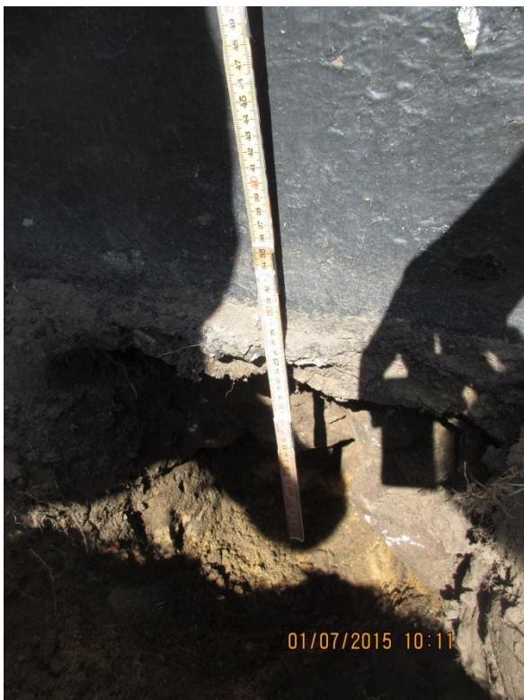
Foto 03+04: Funderingsforhold er 25 cm marksten hvorpå der er opmuret.
