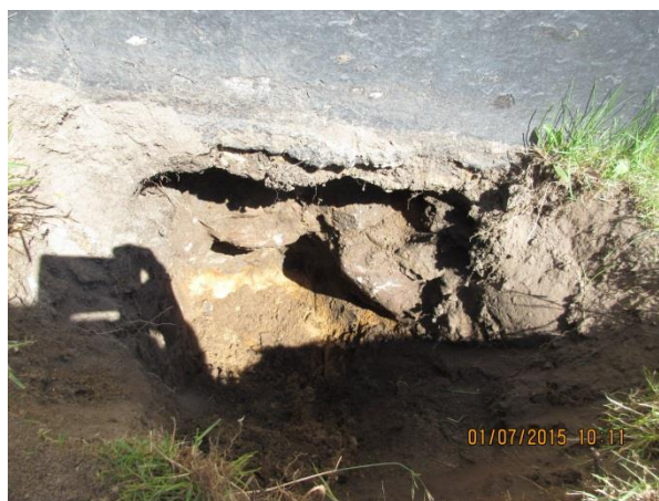
Foto 03+04: Funderingsforhold er 25 cm marksten hvorpå der er opmuret.
