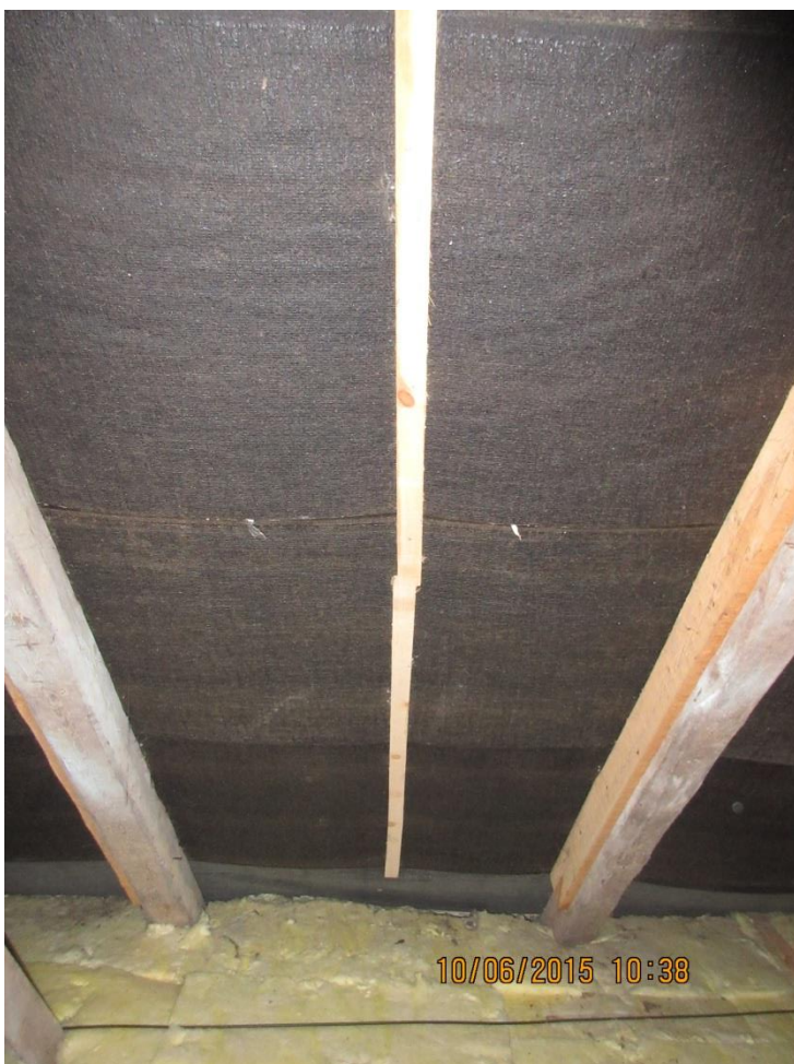
Foto 01: Spærafstand 1,5 m, med monteret mellemlægte under undertaget.
