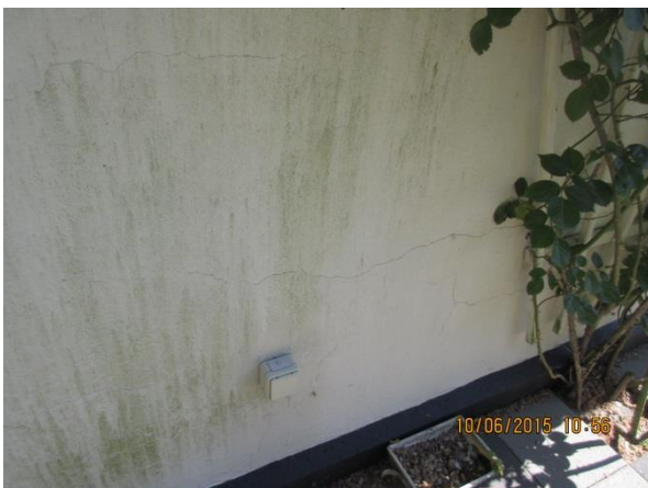
Foto 05+06: Facader er overalt med revner i pudsens.
